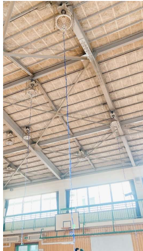
熱電対設置の様子
